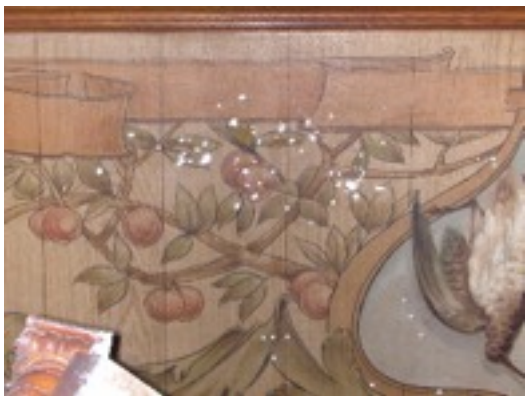
3 Fotos rechts Türen während und nach der Restaurierung
